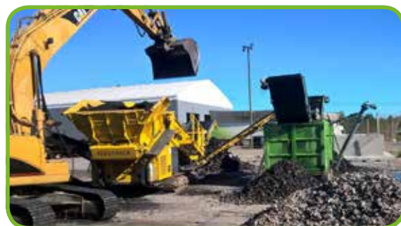
Palaneen kirkon jäänteet lajiteltiin koneellisella menetelmällä, jossa eriteltiin hyödynnettävissä olevat jätteet loppusijoitettavasta jätteestä.
